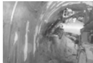
脚部補強ボルト施工状況▶P.33
